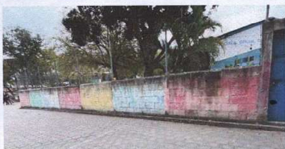
Foto 3: Sustitución de pintura deteriorada de paredes interiores y exteriores del muro de la escuela, por pintura de aceite colores oficiales del MINEDUC.
