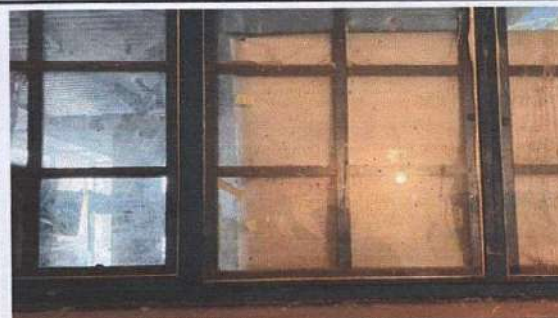
Foto 6: Sustitución de ventana de metal oxidada, por ventana de PVC en el área de la cocina.
