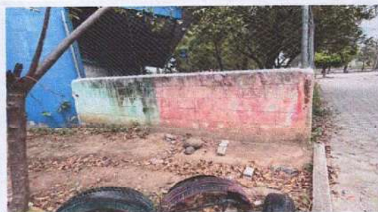
Foto 4: Sustitución de pintura deteriorada de paredes interiores y exteriores del muro de la escuela, por pintura de aceite colores oficiales del MINEDUC.
