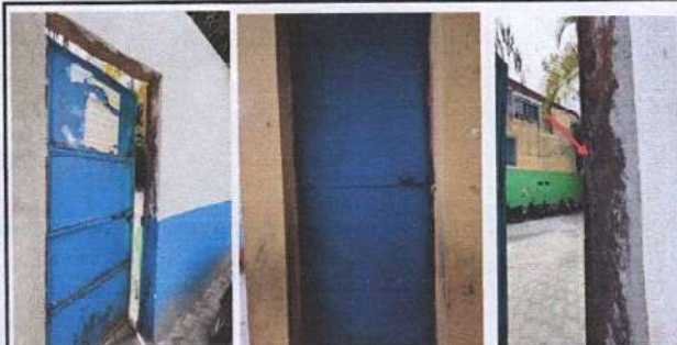
Foto 5: Sustitución de puertas de metal oxidadas de la entrada de la escuela y aula, incluye refuerzo de columna que sostiene la puerta porque está gretada.
