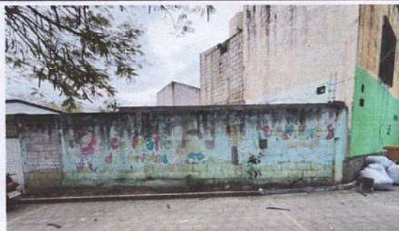
Foto 1: Retoque de mural de identificación deteriorado en paredes exteriores del muro de la escuela, por pintura de aceite.
