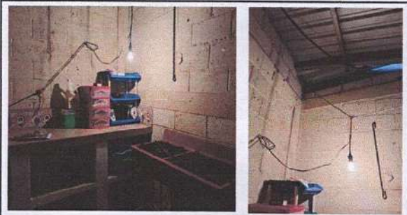
Foto 6: Sustitución de sistema eléctrico de la cocina, lámparas e interruptor ya que se desprendieron los cables del techo y están deteriorados.
