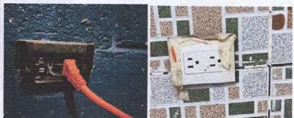
Foto 5: Sustitución de toma corrientes quebrados en el área de la cocina por tomacorrientes nuevos.
