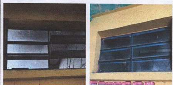
Foto 3: Sustitución de ventanas que no se pueden cerrar porque están oxidadas y les faltan vidrios, por ventanas de PVC, área a intervenir en un aula.
