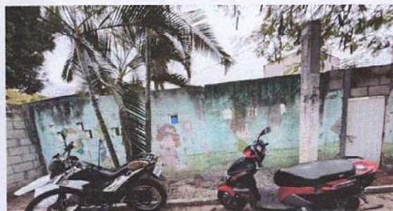
Foto 2: Sustitución de pintura deteriorada en paredes interiores y exteriores del muro de la escuela, por pintura de aceite en colores oficiales del MINEDUC.
